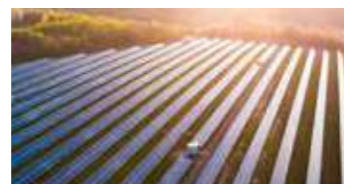
(قريباً): محطة "نور الشمال" للطاقة الشمسية (بالشراكة مع شركة توزيع كهرباء الشمال)
